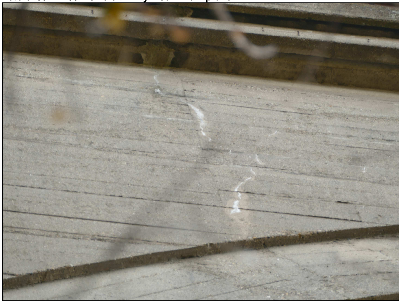
Foto č. 05 – K 03 – svislé trhliny v čelní zdi vpravo
