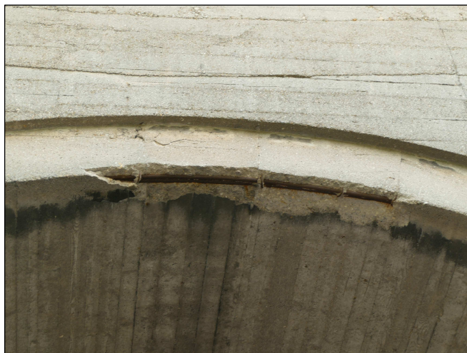
foto č. 2- K 01 – odpadlá dolní hrana vpravo
