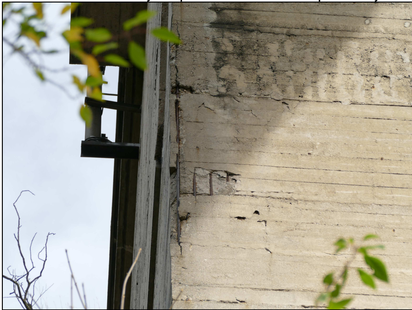
Foto č. 07 – K 05 – obnažená výztuž vpravo nad P 05 v oblasti nad patou klenby
