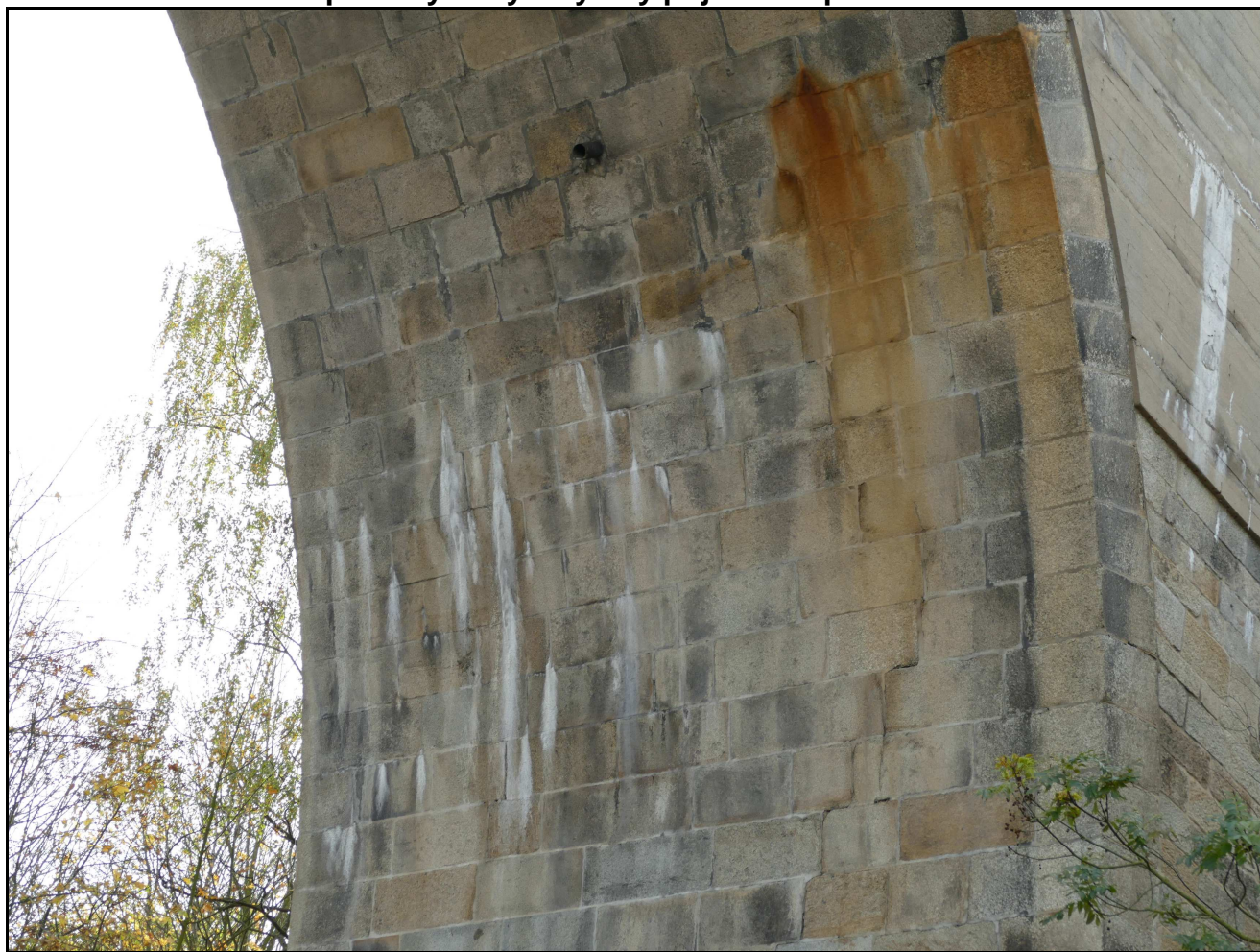
Foto č. 16 – K 14 – průsaky vody a výluhy pojiva nad pilířem P 014
