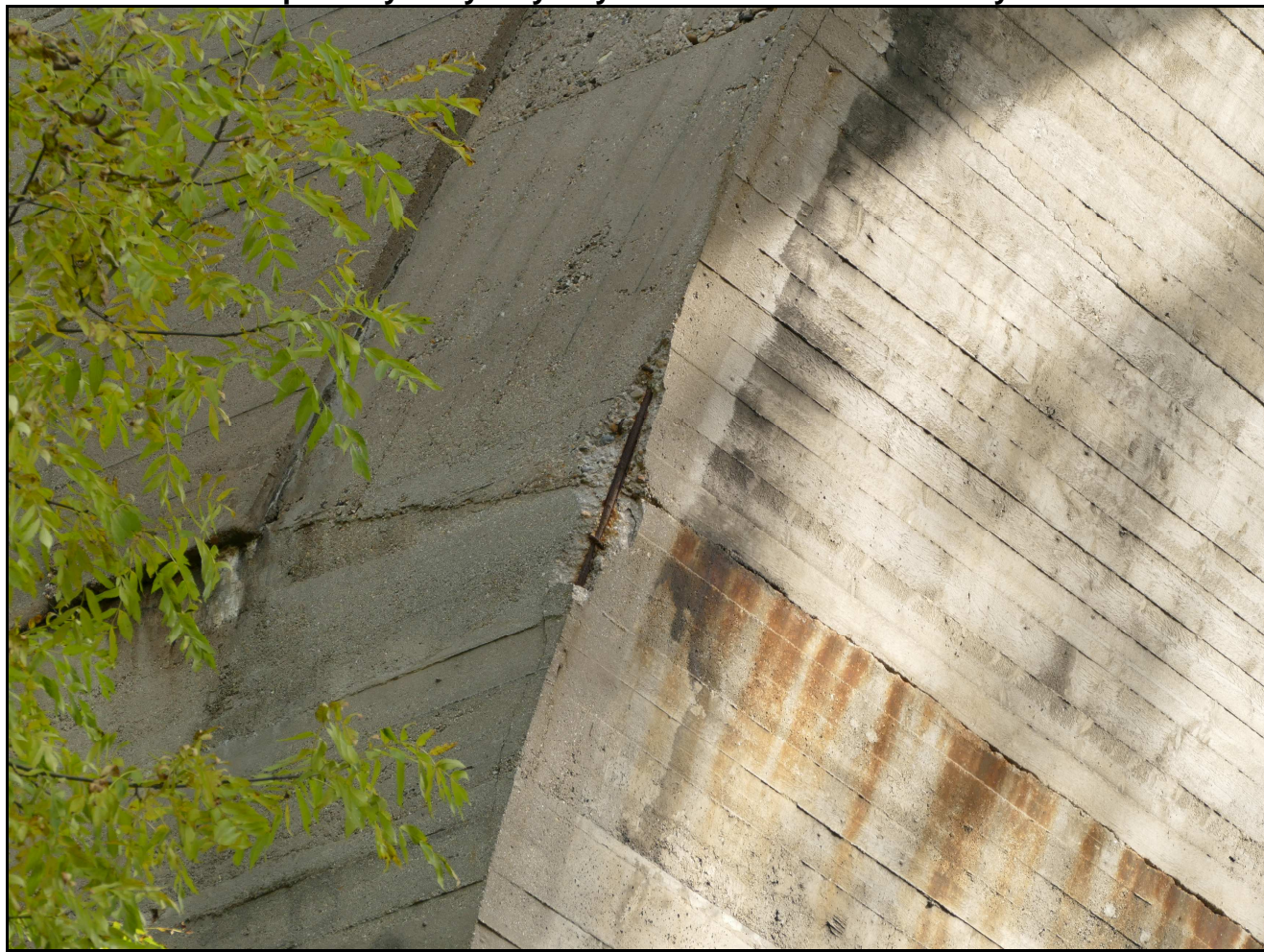
Foto č. 04 – K 03 – průsaky vody s výluhy rzi nad P 02 + obnažená výztuž
