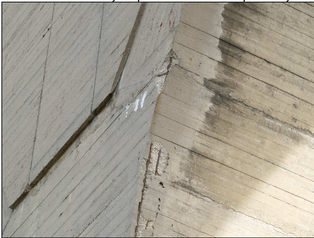
Foto č. 08 – K 05 – obnažená výztuž vpravo nad P 06 v oblasti nad patou klenby
