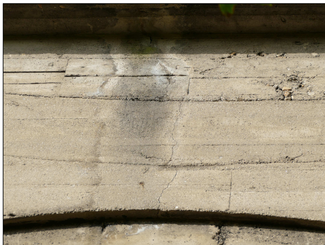
foto č. 01 – K 01 – svislé trhliny v čelní zdi vlevo
